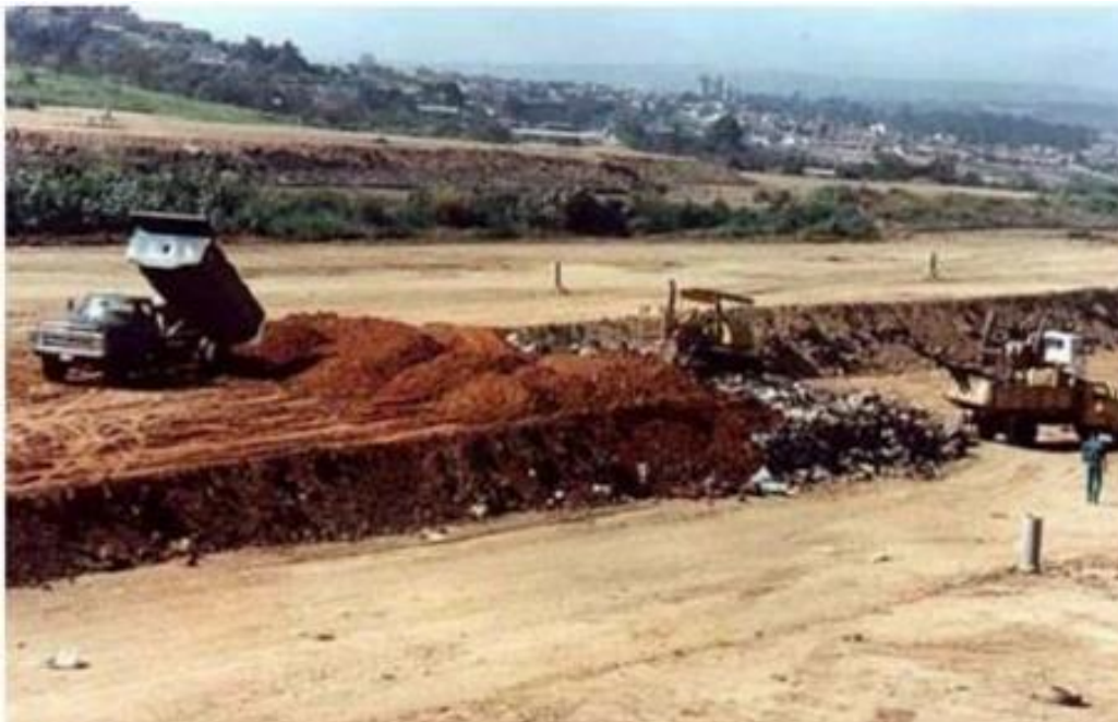
Figura 22: Aterro do RSU em Central de Tratamento de Resíduo (CTR)
