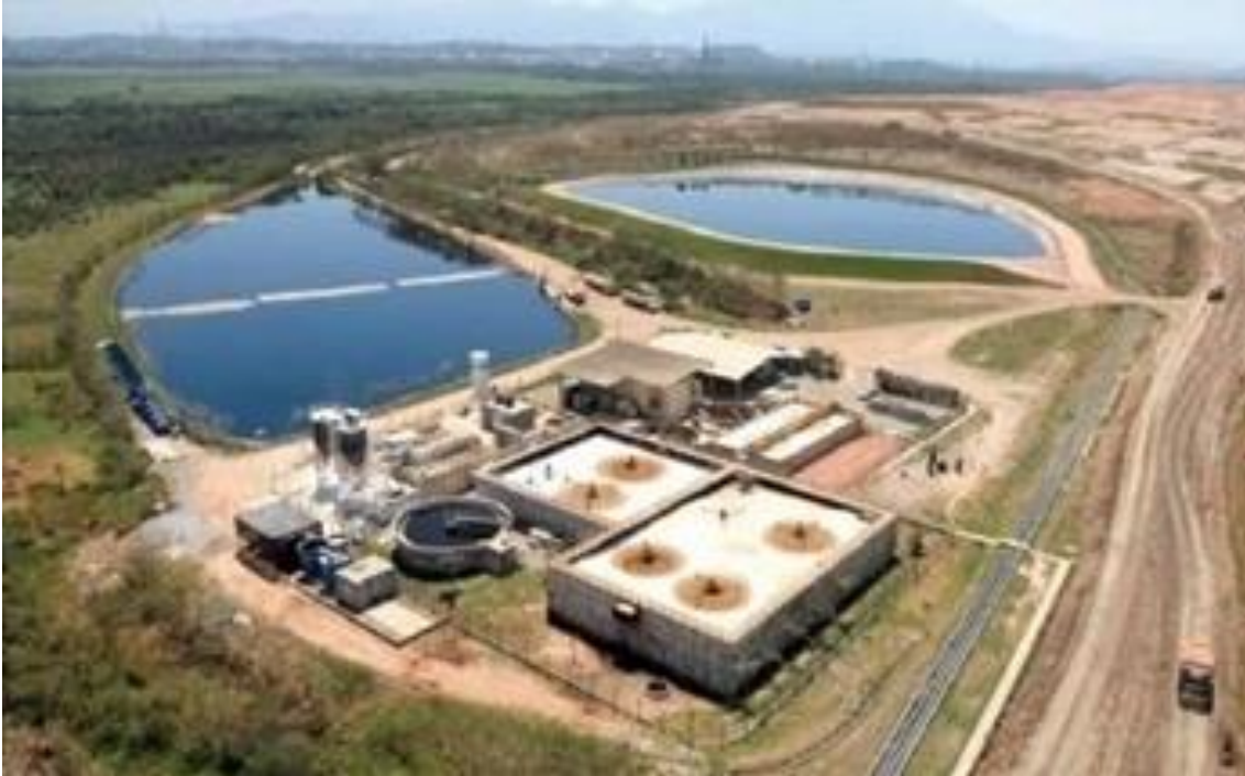
Figura 24: Vista de uma Estação de Tratamento de Chorume
