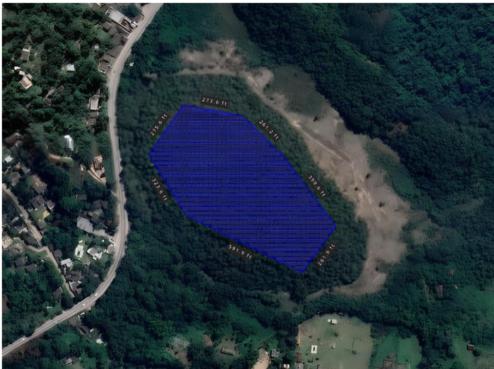
Figura 78: Usina Fotovoltaica Marambaia - 3,48 MW
