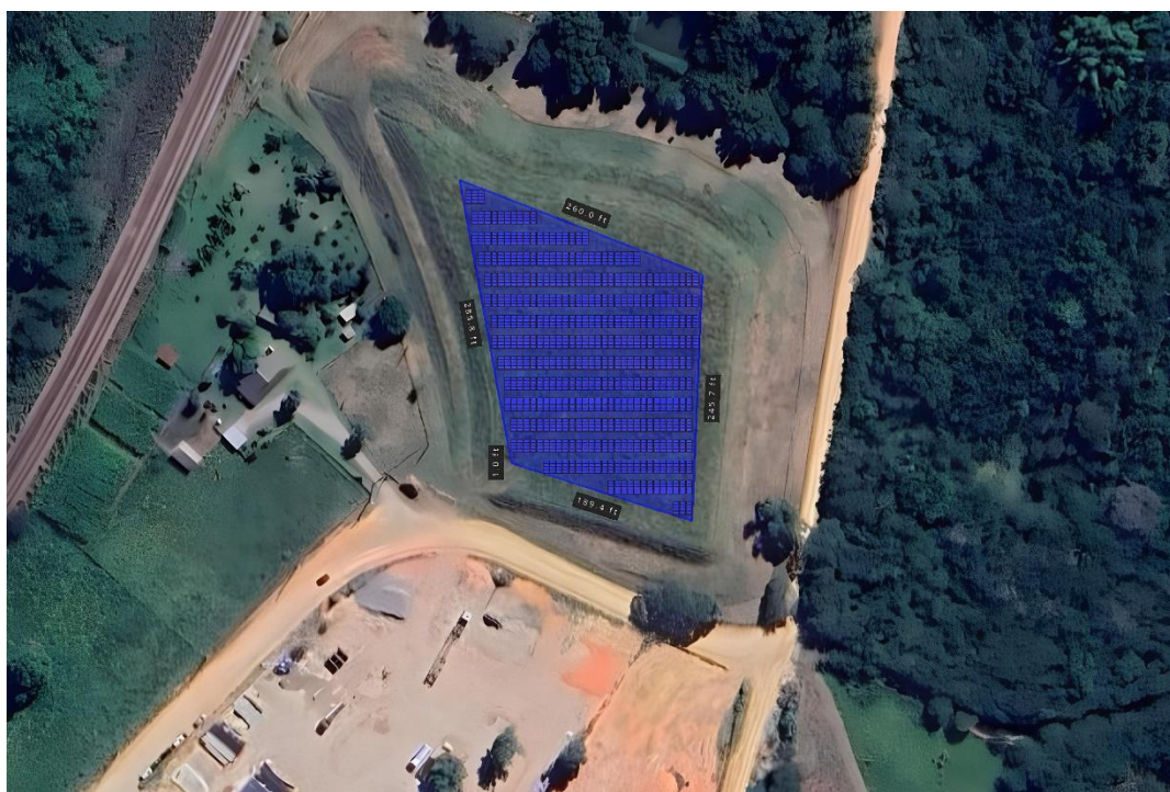
Figura 83: Usina Fotovoltaica Seropédica - 0,50 MW
