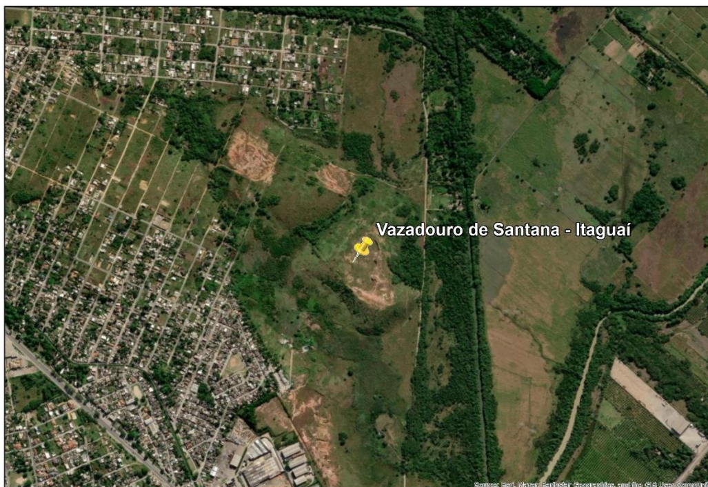
Figura 58: Imagem Aérea do Vazadouro de Santana – Itaguai
