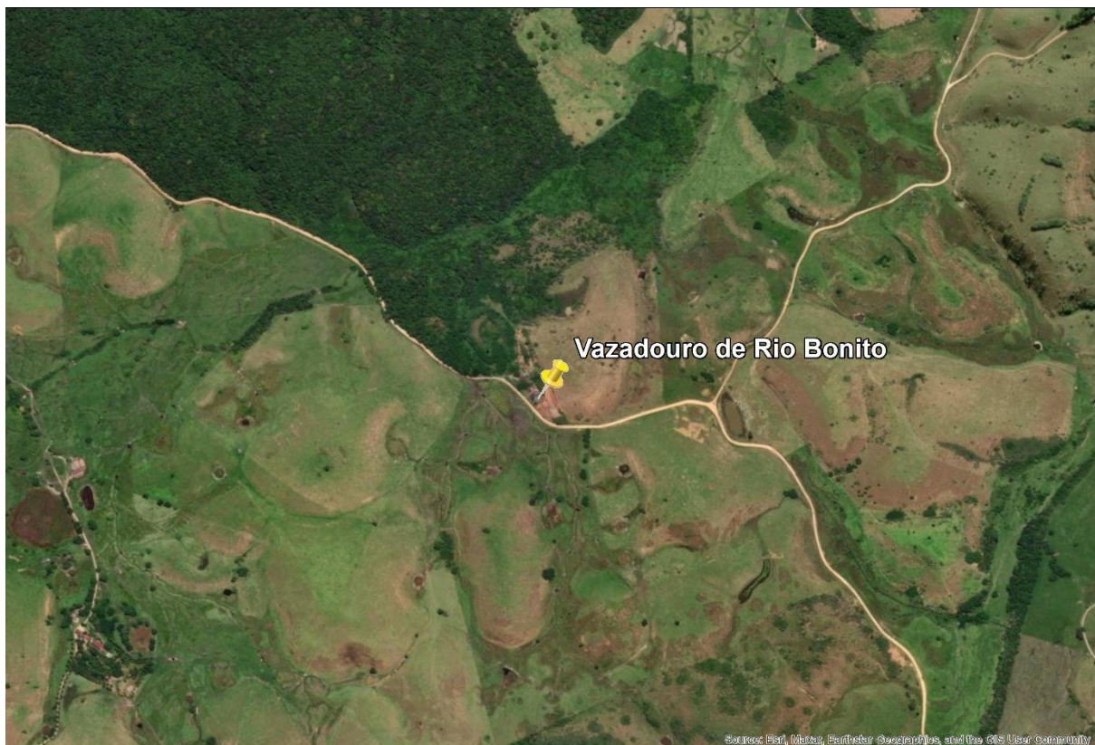
Figura 70: Imagem Aérea do Vazadouro de Rio Bonito
